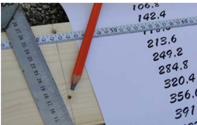
2) Lattenabstände rechnerisch aufsummieren
